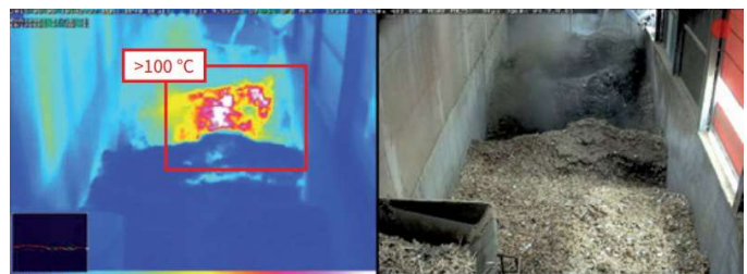
Radiometría térmica (TR): Alarma automática si se sobrepasa el límite máximo o mínimo de temperatura definido
